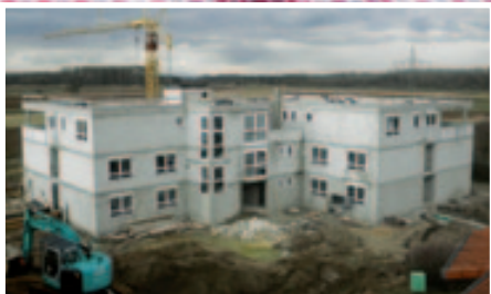
Anbau in der Rheinaue Neues von der Baustelle
